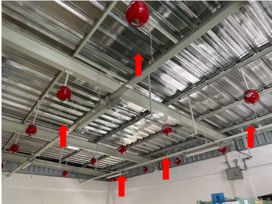
รูปถ่ายที่ 3.2-48 : ระบบดับเพลิง บริเวณอาคารเก็บสารเคมี
