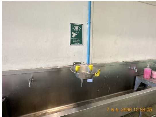
รูปถ่ายที่ 3.2-40 : ฝักบัวฉุกเฉินและอ่างล้างตา
