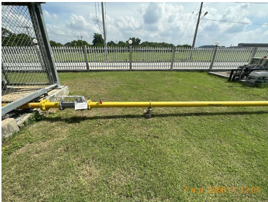
รูปถ่ายที่ 3.2-50 : ป้ายแสดงทิศทางการหมุนวาล์ว และแสดงทิศทางการไหลในท่อขนส่ง
