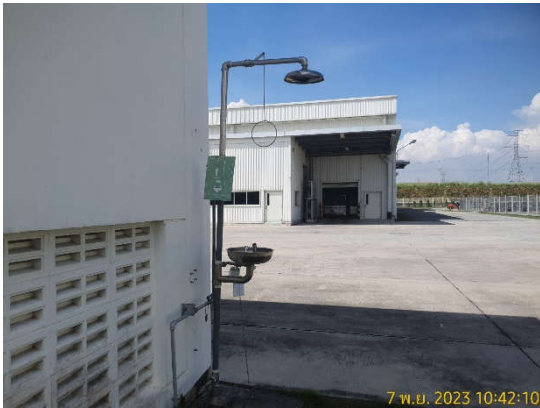
รูปถ่ายที่ 3.2-40 : ฝักบัวฉุกเฉินและอ่างล้างตา
