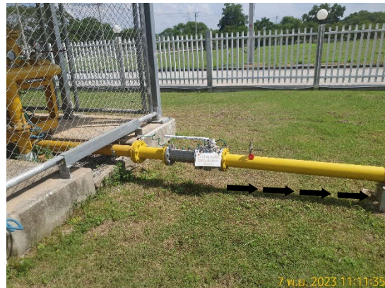
รูปถ่ายที่ 3.2-50 : ป้ายแสดงทิศทางการหมุนวาล์ว และแสดงทิศทางการไหลในท่อขนส่ง
