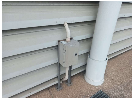
รูปถ่ายที่ 3.2-43 : อุปกรณ์ป้องกันไฟฟ้ารั่ว (สายดิน)
